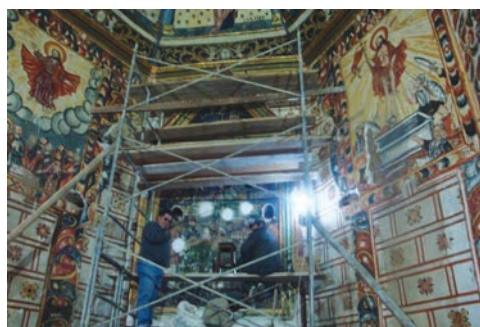
Restauración de la capilla
